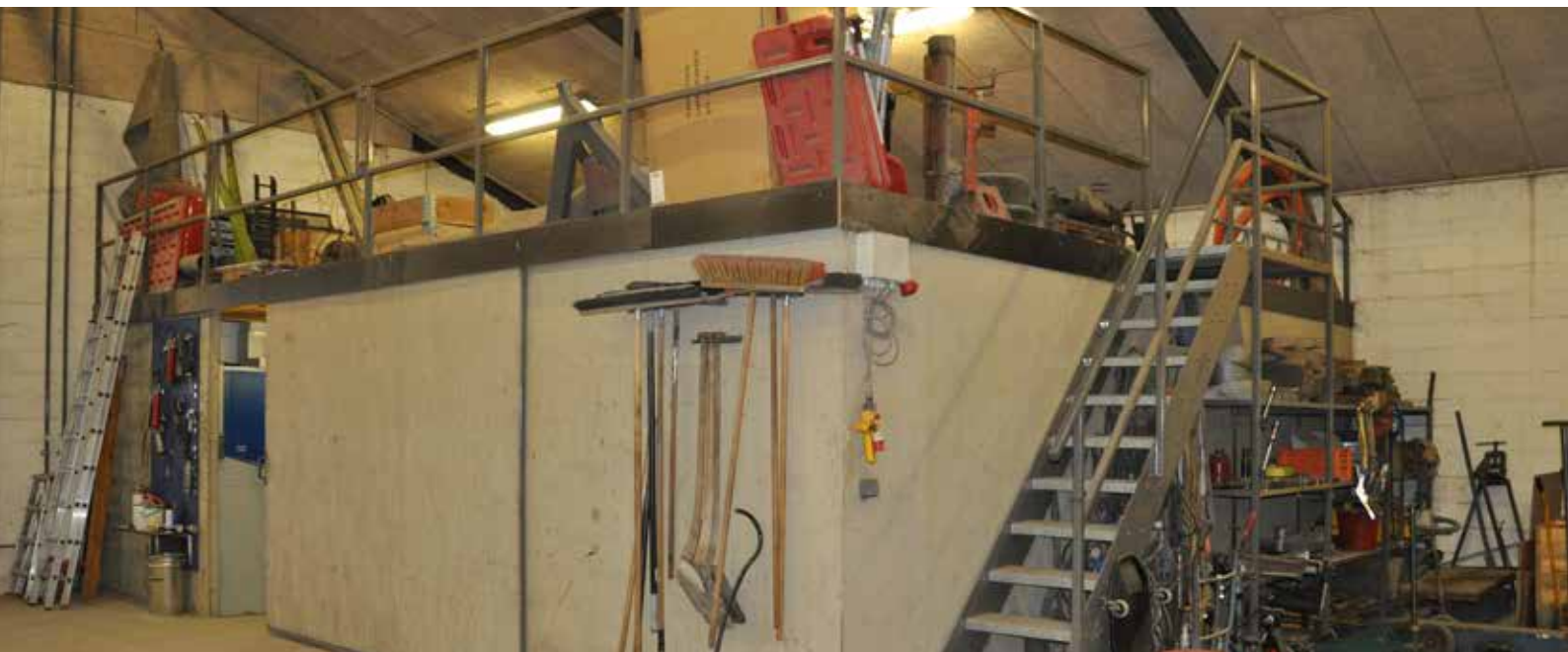
Rækværk over loft i værksted med fod-, knæ- og håndliste.
